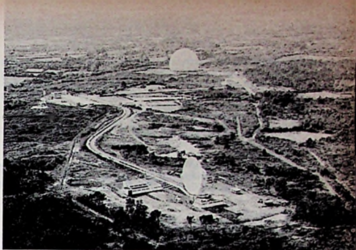
Het Franse grondstation Pleumeur-Bodou. Op de voorgrond de nieuwe parabool, daar achter de radome van Pleumeur-Bodou I.
